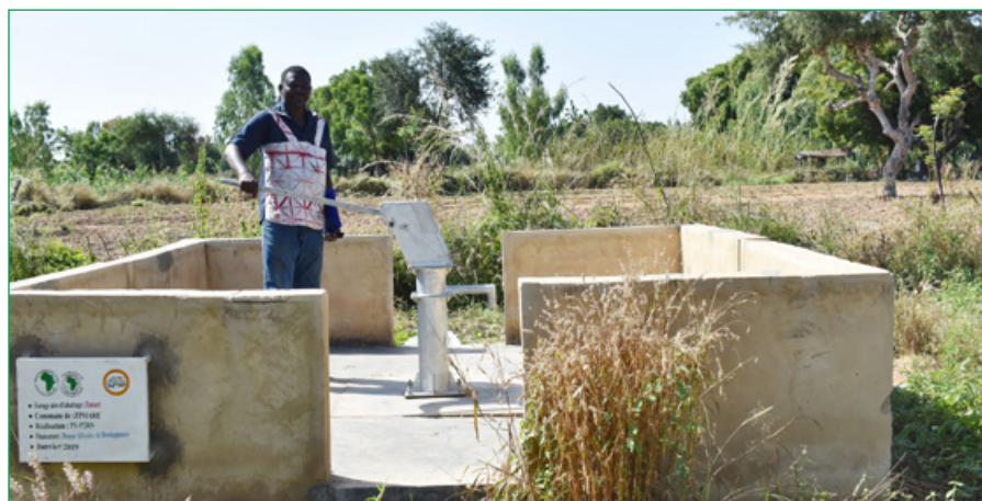
Forage de l'aire d'abattage de Ziniaré
