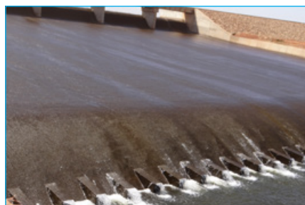
Une vue du barrage de Samandéni.
